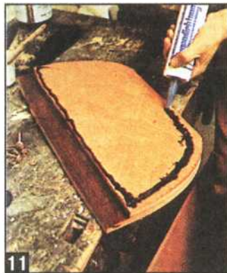
Для крепления подвесного мотора склеивают два куска фанеры, наносят на внутреннюю поверхность склеенного элемента силиконовый каучук и приклеивают фанеру снаружи в середине кормы.
